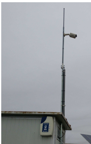
Ejemplo de instalación de antena de radio en caseta usando mástil de cámaras de seguridad
